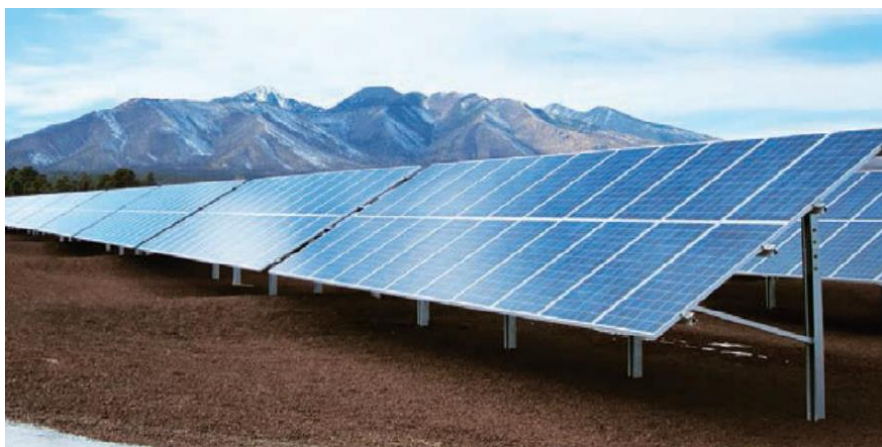
Slika 2.3 Montažna konstrukcija - stol (Izvor: Idejno rješenje)
